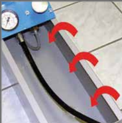
Töltjük fel vízzel a próbapumpát.
